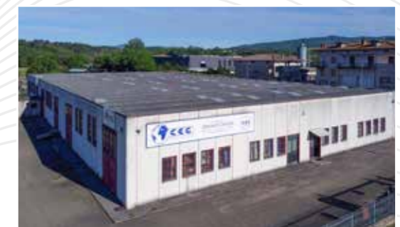
DEPOSITO PRODOTTI FINITI (2.000 m 2 )
