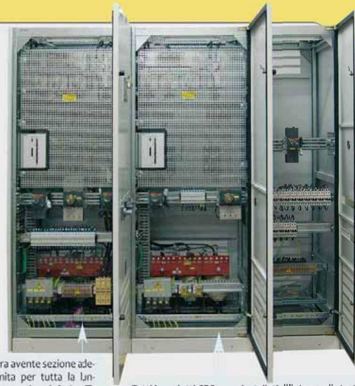
Una barra di terra avente sezione adeguata sarà fornita per tutta la lunghezza del sistema ed avrà fori sufficienti, previsti per il collegamento con la griglia di base.
